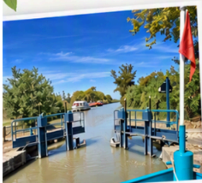
Sur les eaux du Canal du Midi
