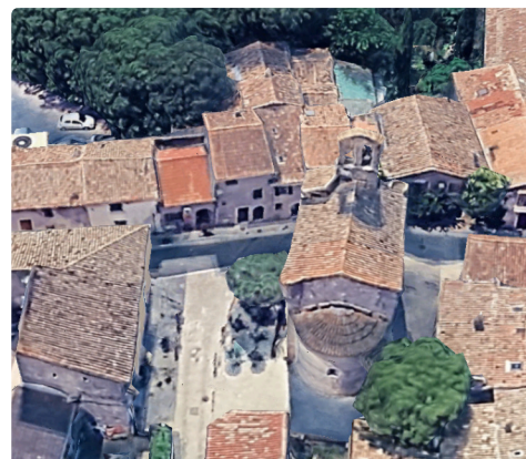
Réfection toiture gîte communal
