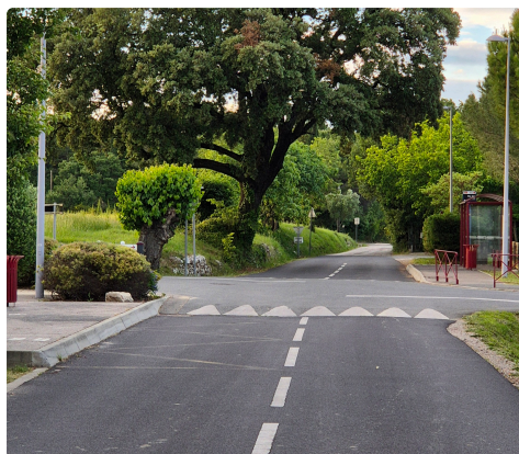
Réfection voirie route des Aires
