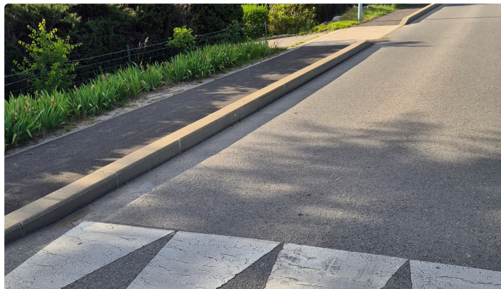
Réfection des trottoirs route d'Assas
